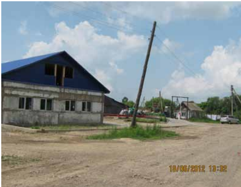
ТОК 2012 год, строится новая контора
